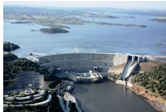
Barragens: EFMA - Alqueva
